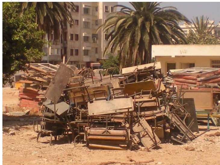
Photo : via Jean-Marcel Alvarez : Ecole du Maarif en démolition : oh nos bureaux d'école ! 02 Sept 2010
